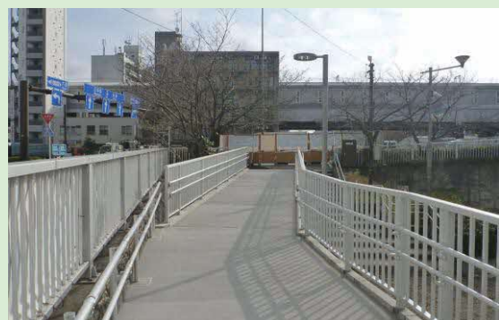
スロープの設置（東海橋船着場）
